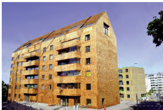
Tòa nhà chung cư 8 tầng bằng gỗ tại Stockholm (Thụy Điển)
